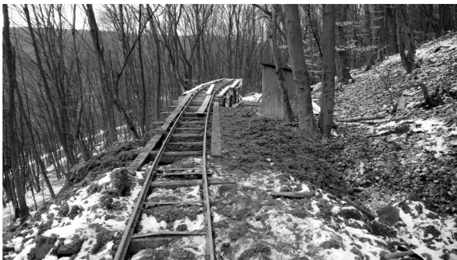
14. ábra: A nagy mennyiségű hordalékot és a meder mélyítésből felszabadult kőzetanyagokat ideiglenes sín pár kiépítésével, kézi erővel történő mozgatóssal juttatták a felszínre Fig. 14. Arge amounts of sediment and rock material released from the dredging have been brought to the surface by the construction of a temporary shingle, manually moved
