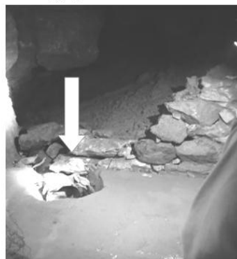
3. ábra: A túlfolyó víz a "Zoltán-terembe" jut, innen túlfolyó-csővön át távozik. Fig. 3. The overflowing water reaches "Chamber Zoltán" and leaves this place through a decantation tube
