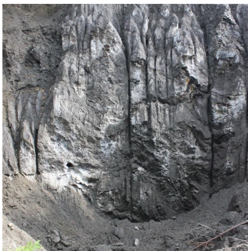
11. ábra: A 2. számú víznyelős dolina a sókőzet repedéseinél alakult ki. Fig. 11: The sinkhole n. 2 developed at the fractured saltrock.
